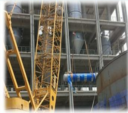
吊装锁斗冲洗水冷却器
