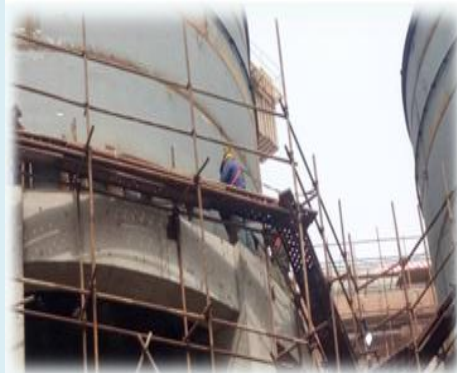
给料煤浆槽筒体焊接
