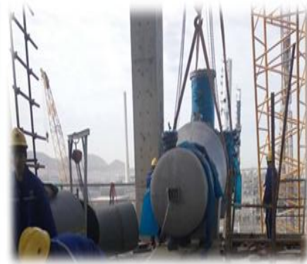
渣水2五层吊装酸性气废热锅炉
