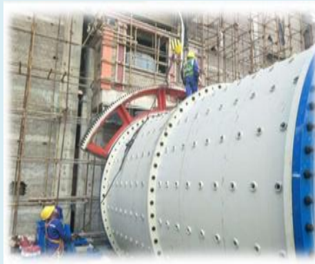
7#磨煤机大齿轮安装
