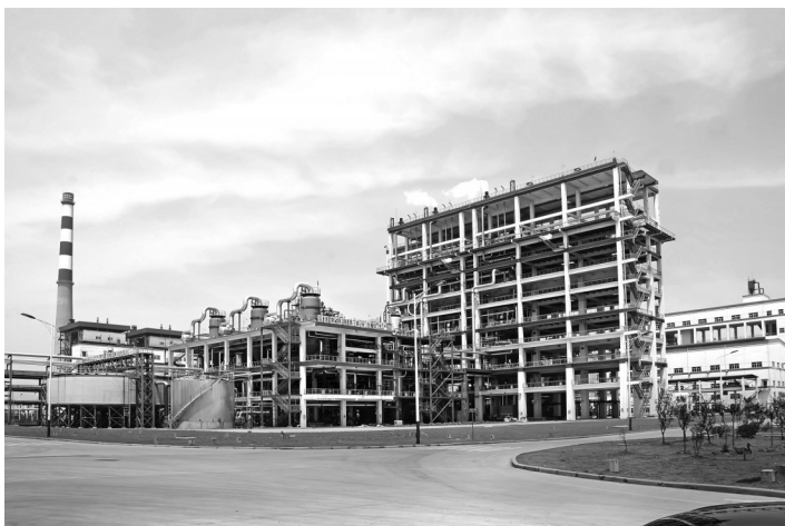
图为江苏索普多喷嘴对置式煤气化装置。
